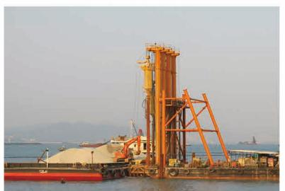
国内首例使用干法底部出料振冲工艺施工的振冲工程，我公司生产的第一代干法底部出料振冲器顺利完成总长度6296米海堤沿线46,000根振冲碎石桩的海上施工，总进尺110万延米。
