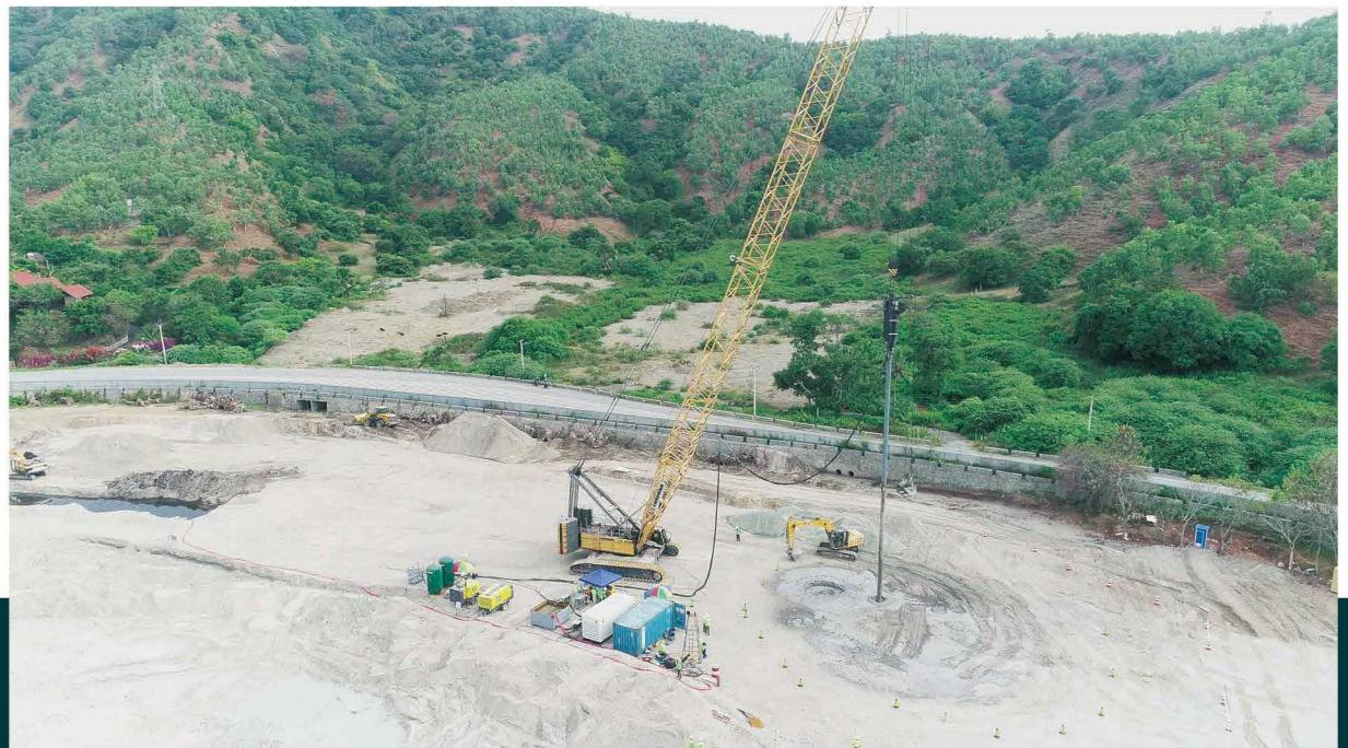
本项目设备顺利穿透SPT值50击的硬质地层并实现底部出料工艺的碎石桩制桩施工。
