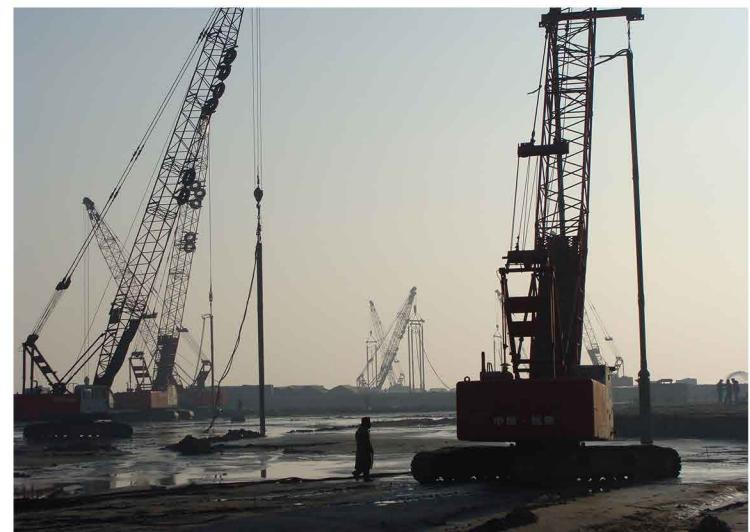
40套我公司生产的BJV75E-426型号振冲器用于本项目原油储油罐和堆场码头的振冲挤密地基处理工程，最大处理深度达到30米。
